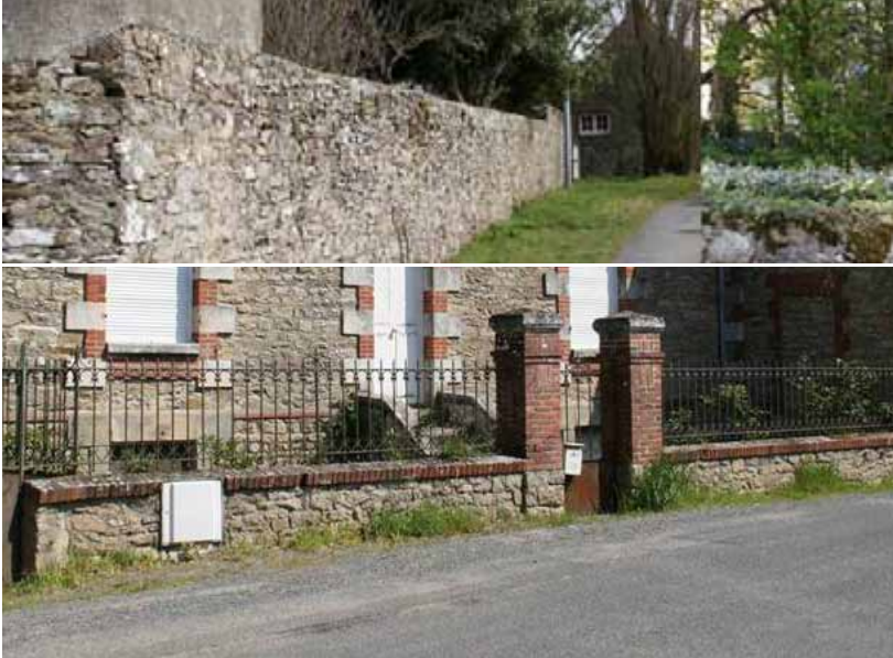
Mur et grille à conserver
