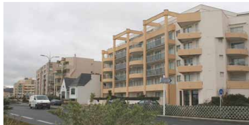
Comment préserver le patrimoine restant sur le front de mer?
