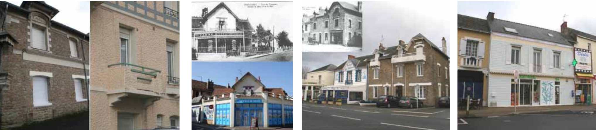
La dégradation du bâti par la pose d'éléments standards, la perte des décors, la modifications des balcons, l'ajout de bardage PVC...
