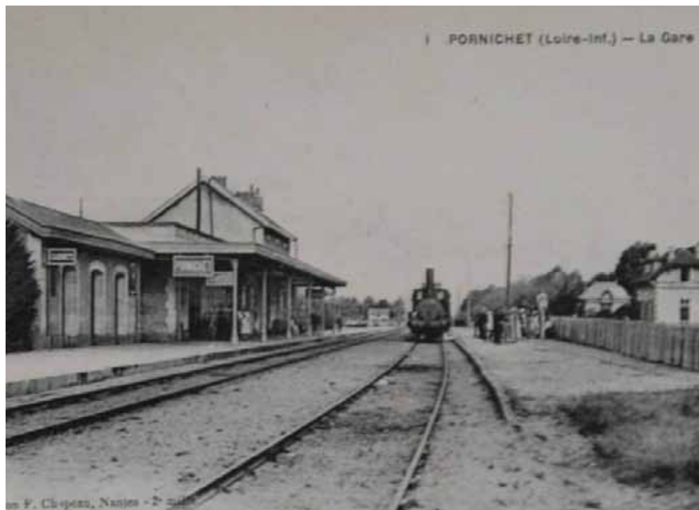
Gare de Pornichet
