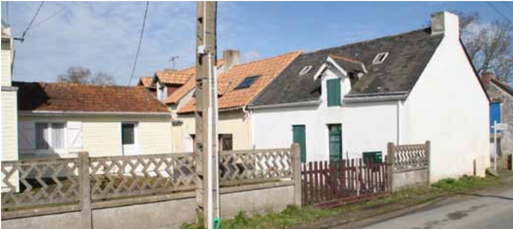
Façade de l'habitation orientée sud, dépendances à l'ouest
