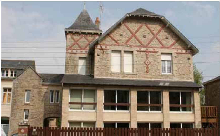
Extensions sans rapport avec la construction d'origine et qui dénaturent l'aspect de cette dernière
