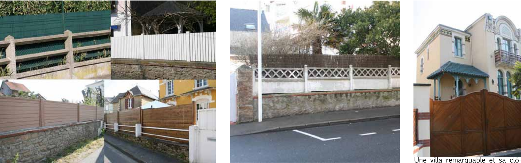
La multiplication des systèmes de clôtures : claire-voie et par-vue ou clôture bois ou PVC...
