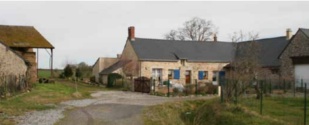
Façade de l'habitation orientée plein sud
