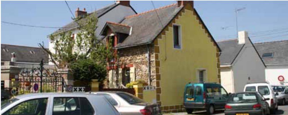
Façades de l'habitation orientées sud
