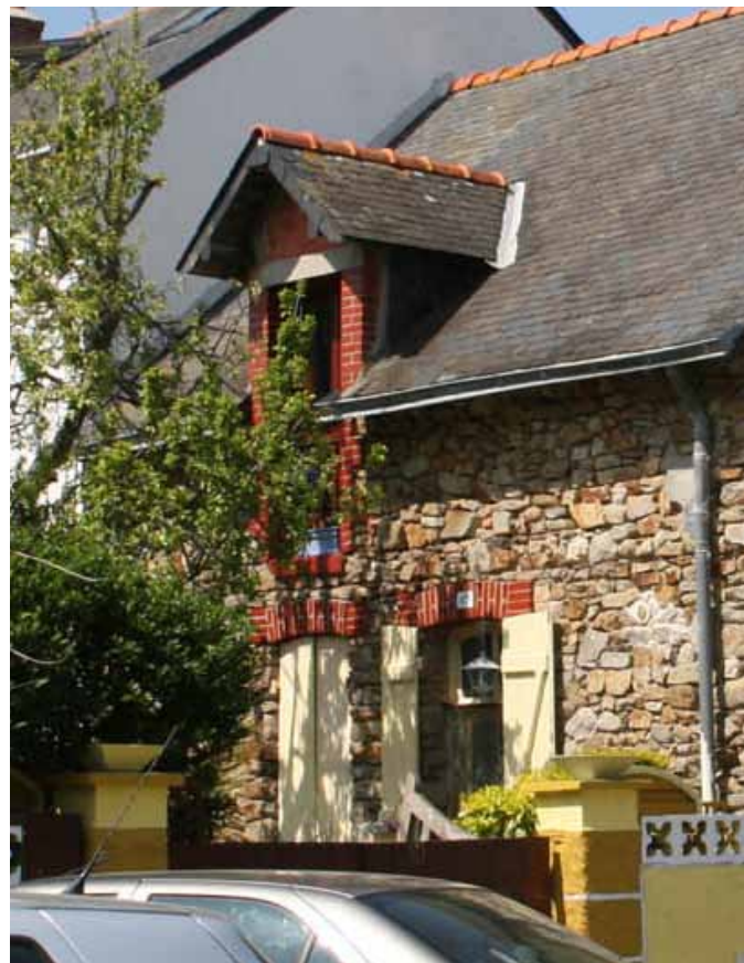
Mur en moellons de granite, charpente en bois, et couverture en ardoises
