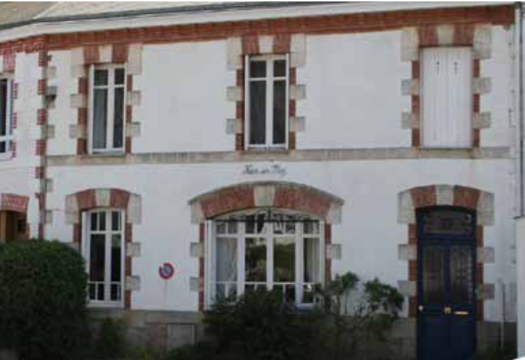
Façades recouvertes d'un enduit et badigeon
