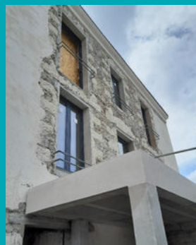
Nov. 2023 : façade nord, réalisation des enduits chaux sur le mur historique en pierre.
