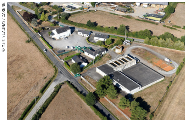
Usine de production d'eau de la CARENE à Campbon.
