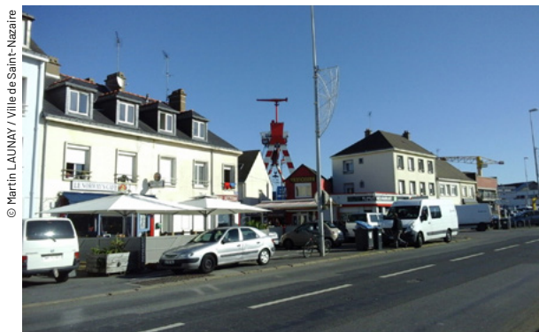
Avenue de Penhoët avant travaux.
