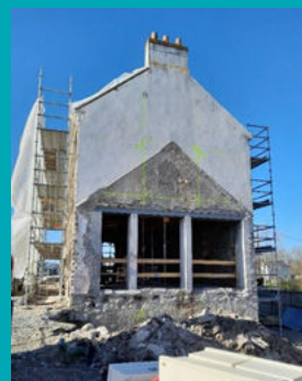
Fév. 2023 : ouvertures en pignon vers la future extension.
